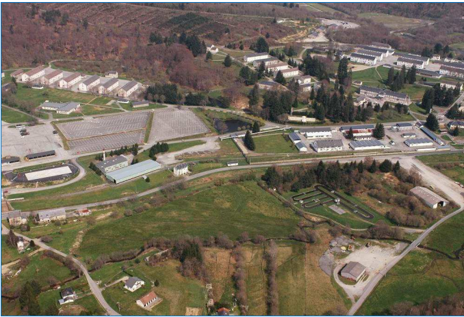
Partie centrale du Camp bâti de La Courtine et station d'épuration du site
